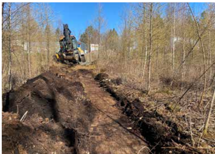
Figur 3. Sökschaktning av det norra området, i lärkplanteringen.
