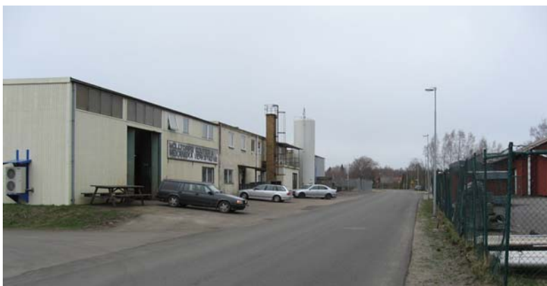
Mölltorps gjuteri. Smälter och gjuter järnprodukter för annan tillverkningsindustri, tillverkar designprodukter i form av till exempel gatubelysning samt detaljer i rostfritt och aluminium. Företaget har tillstånd från länsstyrelsen för verksamheten.
