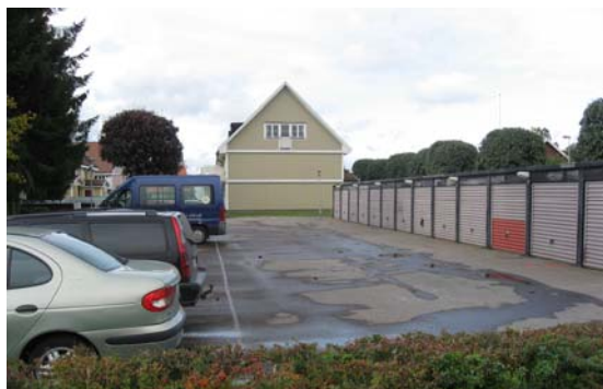
Befintlig garagelänga utmed Mellangatan.
