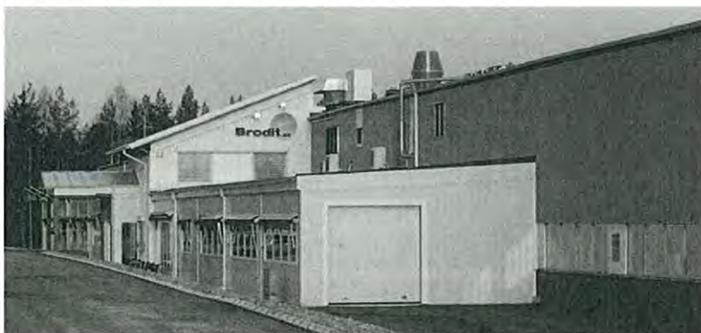
Luxorhuset (övre bilden) med vattentornet till höger i bakgrunden och Brodit Plast (nedre bilden).
