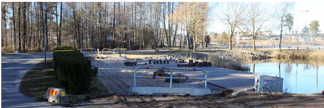
Rastplats under ombyggnad
