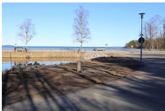
Förbättringsarbeten vid Öltappen
